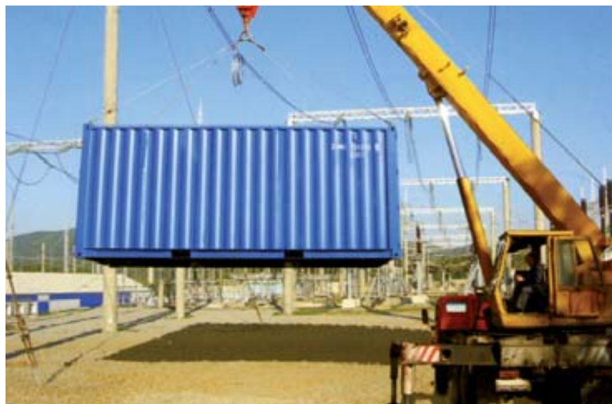
Монтаж ВУПГ на объекте
