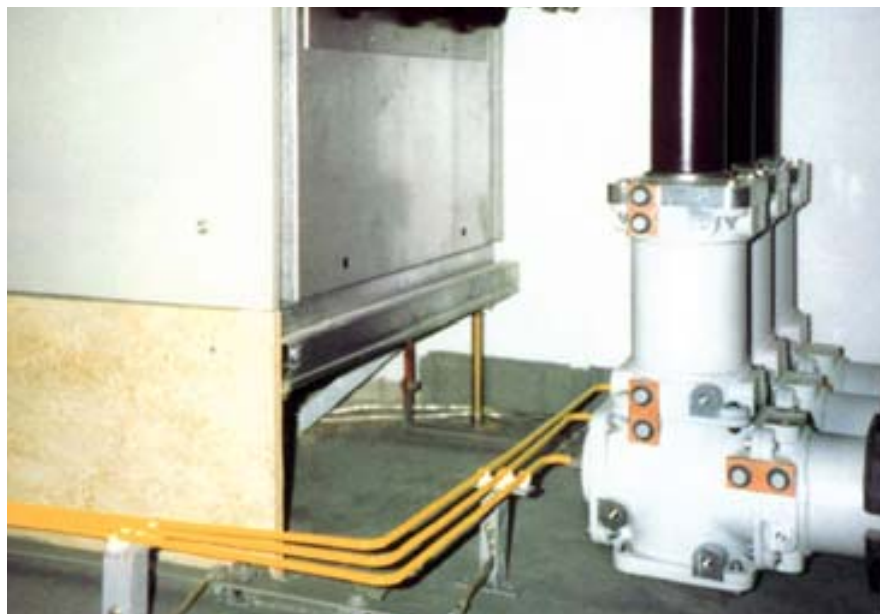
Пример установки шинопровода Gaslink с элегазовой изоляцией фирмы MGC Moser-Glaser
