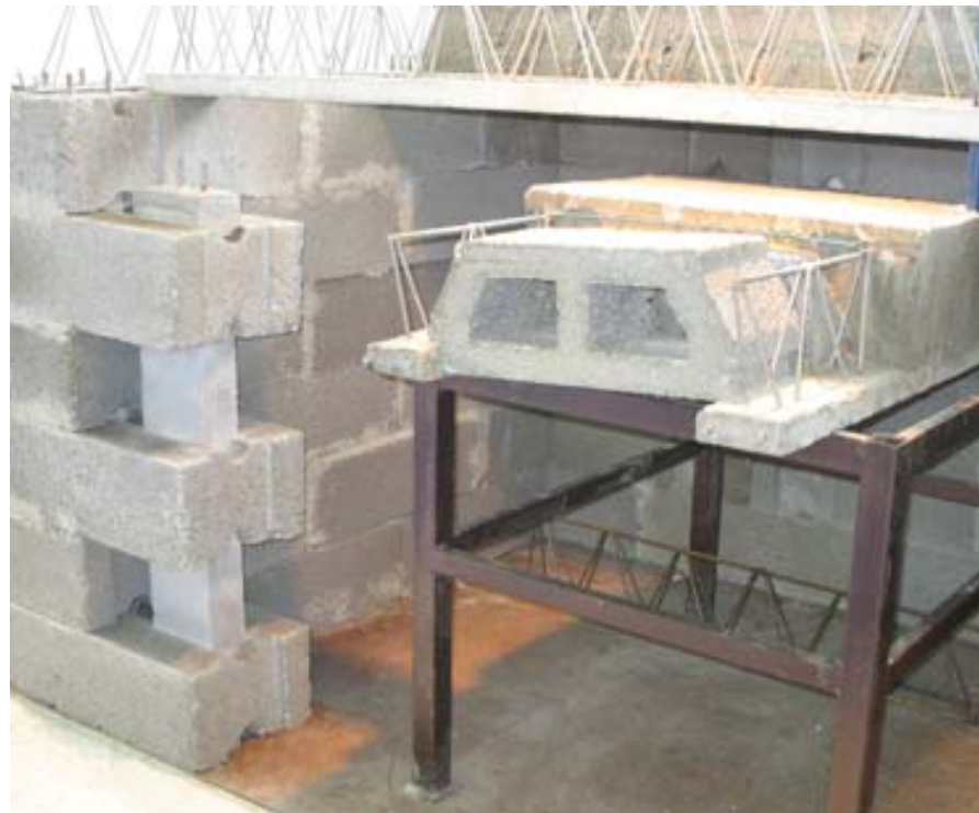
Основные элементы системы монолитного строительства «Марко»: стеновые блоки и сборно-монолитное перекрытие
