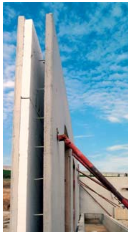
Термоанкеры для скрепления панелей наружных стен
