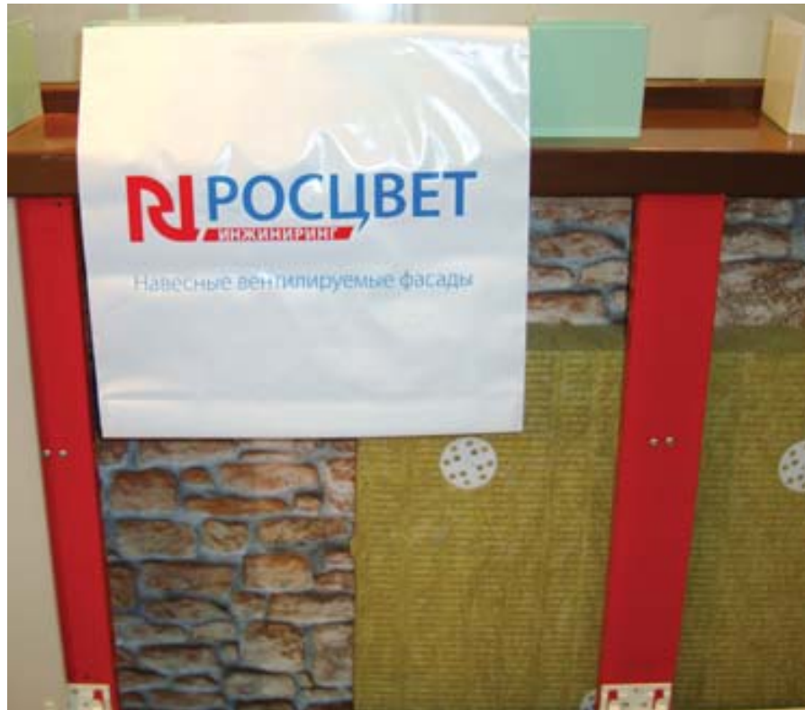
Система крепления навесного вентилируемого фасада ООО «Росцвет Инжиниринг»
